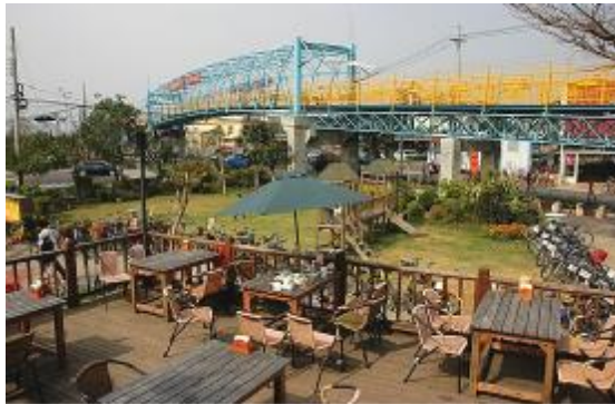
（圖四）崇德路自行車專用陸橋 及橋下的休閒餐廳（註七）
